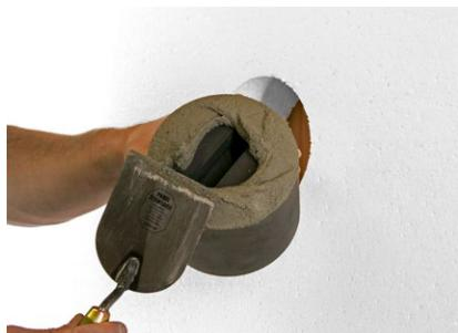
EPS-Stopfen aus der Nische herausnehmen und auf die Klebefläche der Universalmontageplatte UMP®-ALU-Z Klebemörtel aufziehen. Element muss vollflächig auf den tragfähigen Untergrund verklebt werden.
