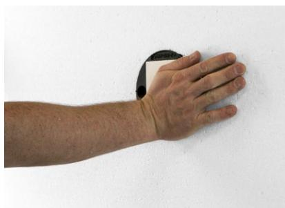
Universalmontageplatte UMP®-ALU-Z dämmplattenbündig anpressen.
