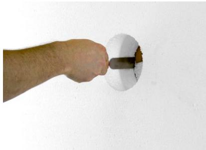
Restdicke mit geeignetem Werkzeug herauskratzen und Ausfräsum vom Frässtaub reinigen.
