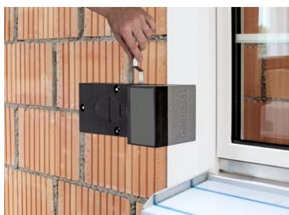
Regolare la posizione dell'staffa TWL®-ALU-RF attraverso i piedini di regolazione in modo che sia a filo con la facciata. Campo di regolazione 5 – 15 mm.
