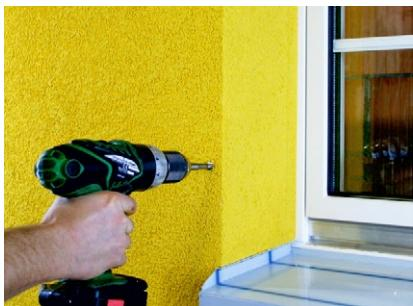
Gewinde durch die Compact- und Aluplatte schneiden.
