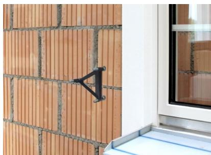
Inserire le aste filettate e posizionarle con esattezza utilizzando il posizionamento calibro per TRA-WIK® e TWL®. Lasciar indurre la malta iniettata. Dopo l'indurimento, rimuovere il posizionamento calibro e il materiale in eccesso. Per quanto riguarda le opere murarie, utilizzare tassativamente delle bussola d'ancoraggio per iniezione.
