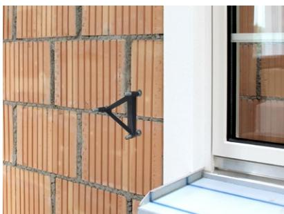
Gewindestangen setzen und durch Aufstecken der Setzlehre für TRA-WIK® und TWL® genau ausrichten. Injektions-Mörtel aushärten lassen. Nach dem Aushärten Setzlehre abziehen und überschüssiges Material entfernen. Bei Mauerwerk mit Lochsteinen müssen zwingend Injektions-Ankerhülsen verwendet werden.
