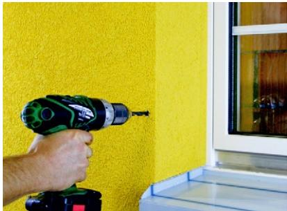
Bohrloch durch die Compact- und Aluplatte bohren.
