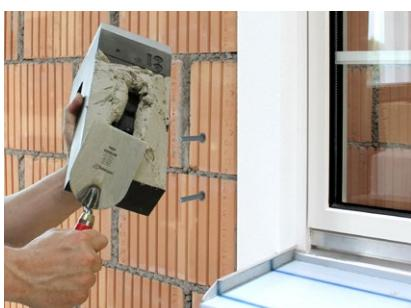
Auf die Klebefläche des Tragwinkels TWL®-ALU-RF Klebemörtel aufziehen. Element muss vollflächig auf den tragfähigen Untergrund verklebt werden.
