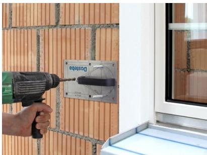
Bei der Bohrlehre für UMP®, TRA-WIK® und TWL® eine Gewindestange in das dementsprechende Loch stecken.
