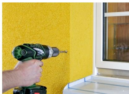
Gewinde durch die Compact- und Aluplatte schneiden.
