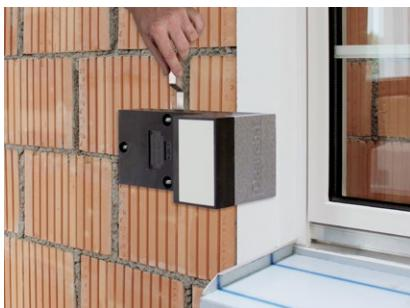
Mit den Stellfüßen Tragwinkel TRA-WIK®-ALU-RF auf Fassadenflucht ausrichten. Verstellbereich 5 – 15 mm.
