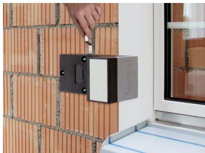
Regolare la posizione della staffa TRA-WIK®-ALU-RF attraverso i piedini di regolazione in modo che sia a filo con la facciata. Campo di regolazione 5 – 15 mm.
