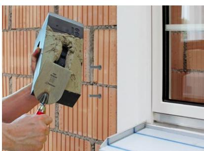
Auf die Klebefläche des Tragwinkels TRA-WIK®-ALU-RF Klebemörtel aufziehen. Element muss vollflächig auf den tragfähigen Untergrund verklebt werden.
